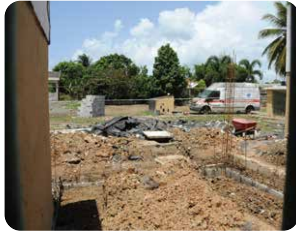
Supervisión de remodelación Hospital Alicia de Legendre.
